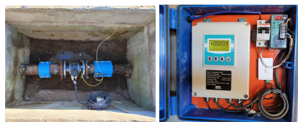
Fig 1.: Macromedidor en Planta
